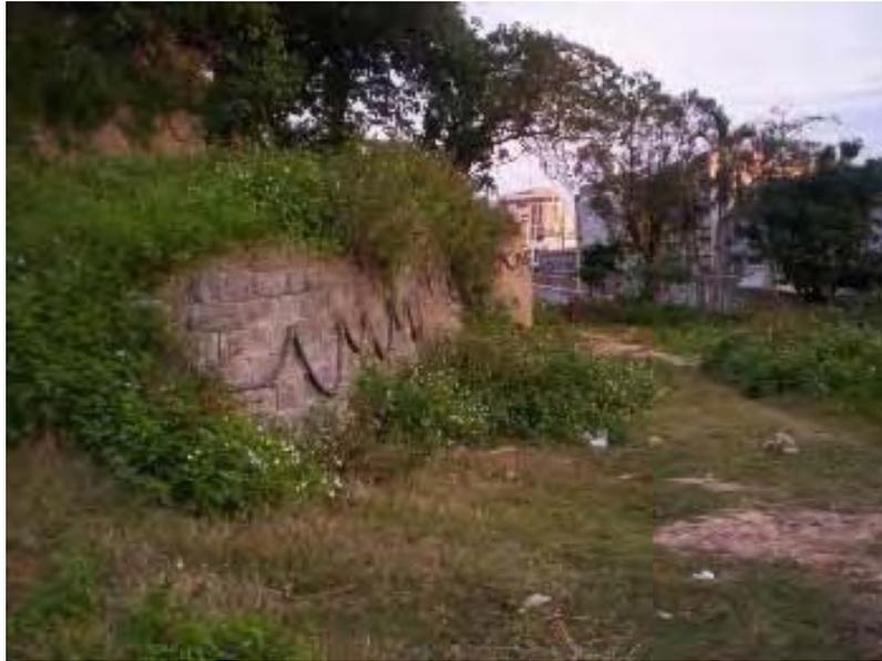
圖 2.13 疊塊式模鑄面版擋土牆
