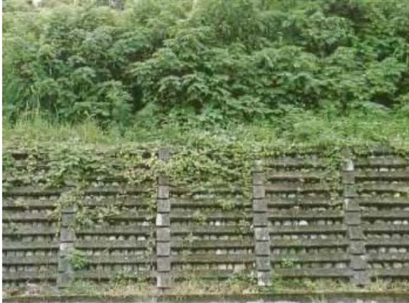
圖 2.15 混凝土格框擋土牆
