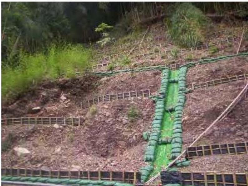
圖 2.22 打樁編柵工法
