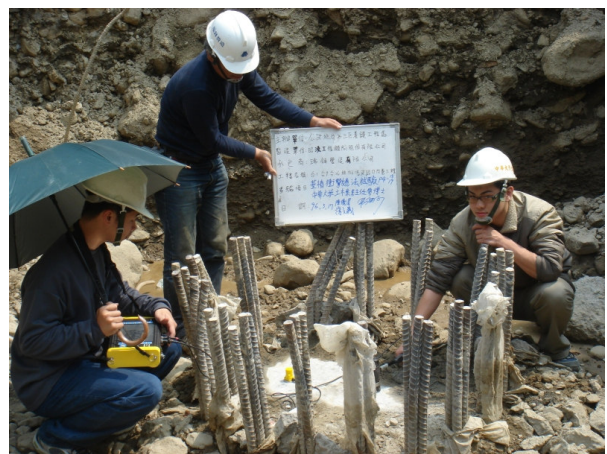
圖五 屏東楓港現地檢測基樁之照片
