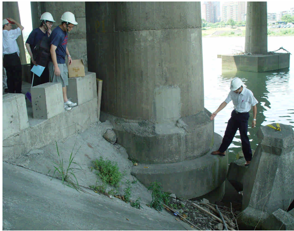
圖二 P1 墩柱下受測沉箱之照片
