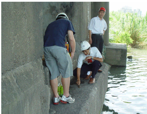
圖三 P1 墩柱受衝擊反應檢測前之沉箱頂表面平整處理之照片
