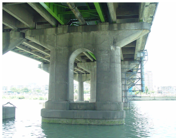
圖一 中正橋墩柱基礎之照片
