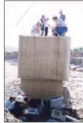
圖四 群樁基樁進行現地衝擊檢測之情形。
