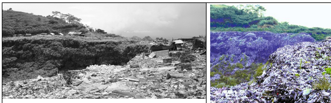
圖 4.8 破壞後殘餘邊坡(Kölsch et al., 2005)
