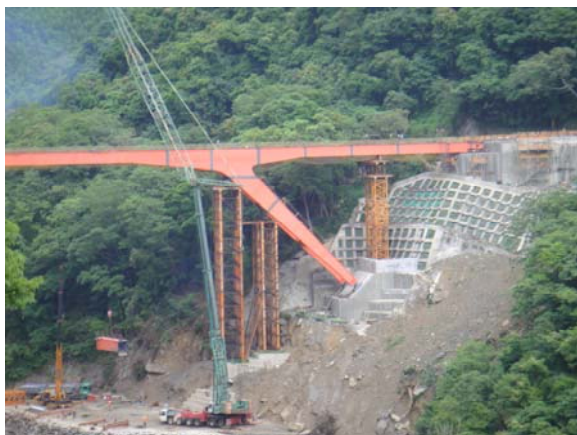
GB01鋼樑吊裝情形
