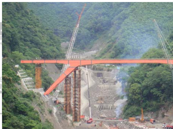
GA21鋼樑吊裝情形
