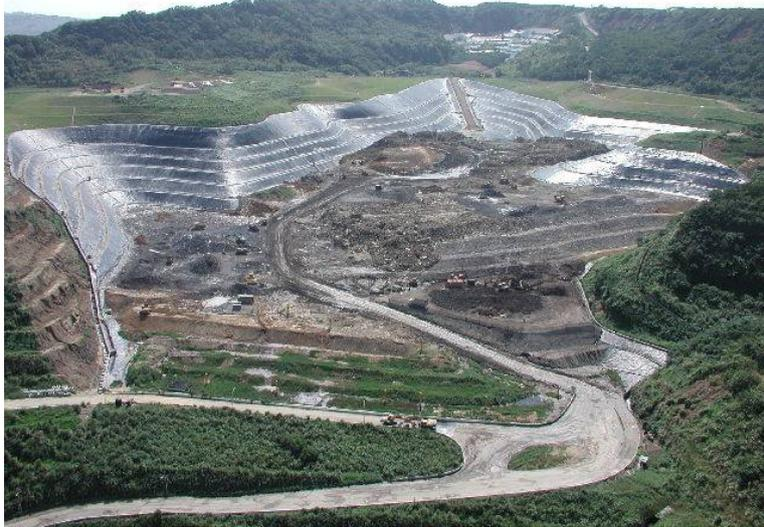
圖 3-4 不透水布鋪設及掩埋面作業區
