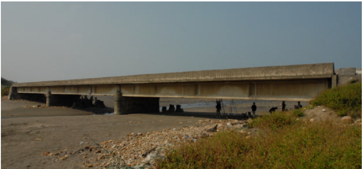
圖三、桃園縣新屋鄉新濱二號橋
