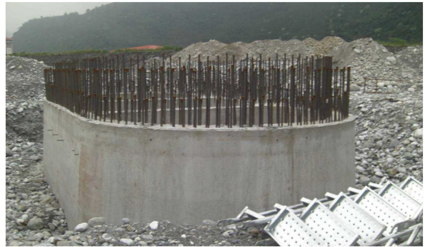
圖 8 花蓮壽豐溪橋現地長圓形複合式沉箱之照片
