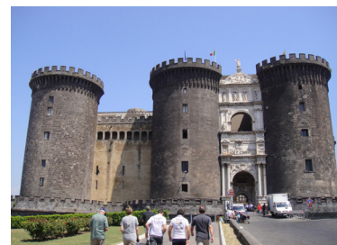
照片 27 拿坡里的 Nuovo 城堡
