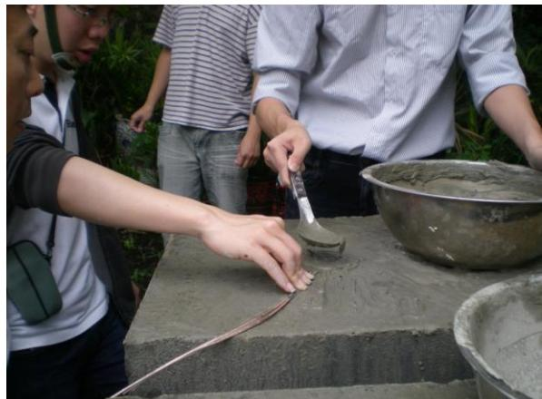
圖六 回填混凝土至鑽孔之照片
