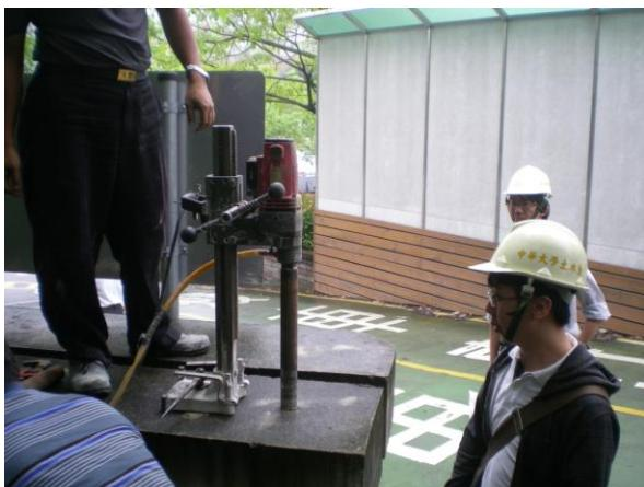
圖三 現地小型含樁帽基樁進行鑽芯工程
