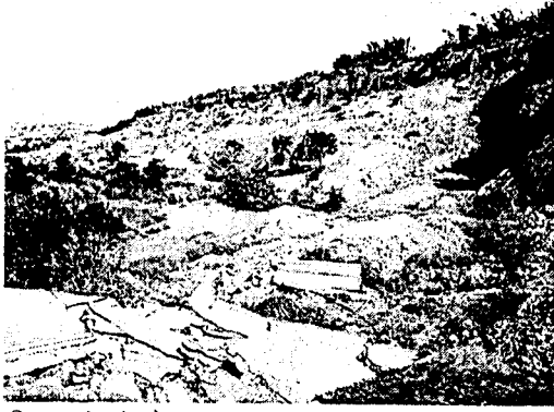
圖 3 山坡地事故可嚴重改變當地之環境與生態
