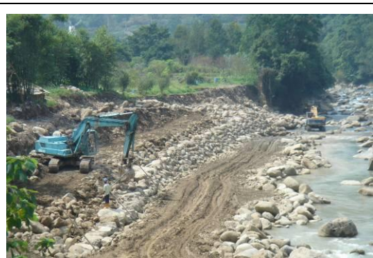
圖 5.1-14 封溪河段堤岸施工情形
