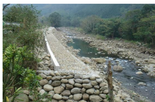
圖 5.1-16 封溪段沿溪堤岸步道
