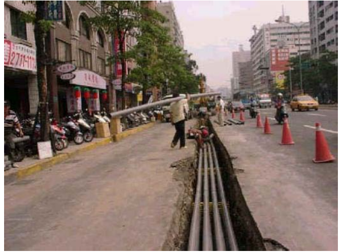
(2) 開挖完成後，於管溝內安裝管線
