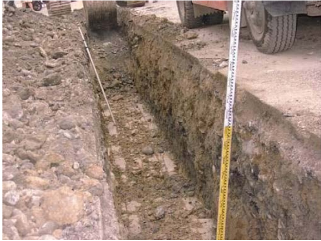
(1) 管溝開挖完成
