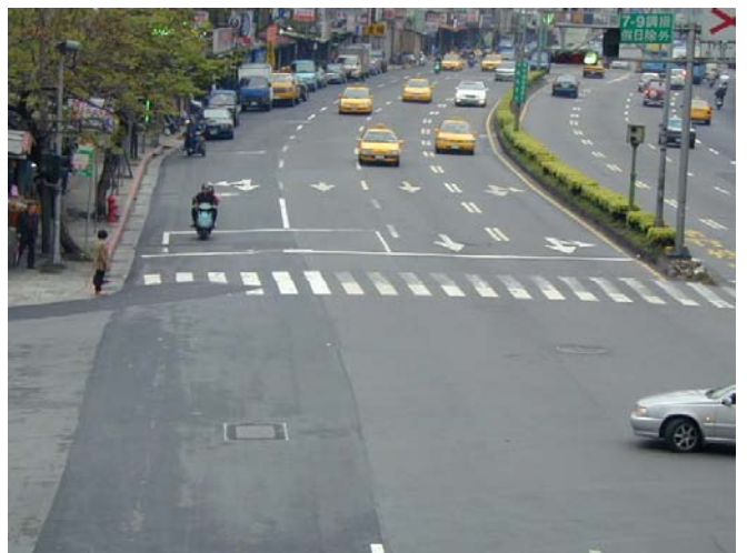
(6) 完工後，路面現況全景圖
