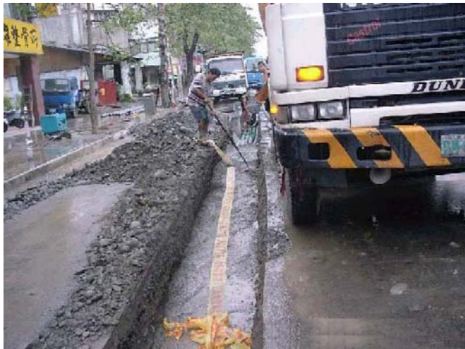
(3) 由預拌混凝土車直接澆置 CLSM 回填料
