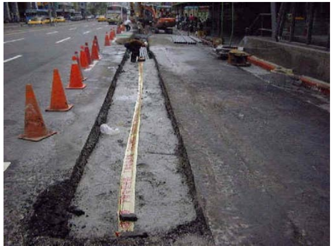
(4) CLSM 澆置入管溝(不須搗實)把平後，鋪放警示帶
