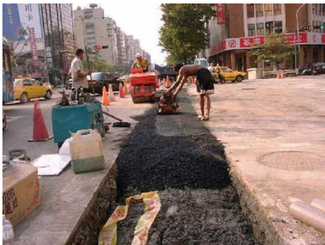
(5) 待 CLSM 凝結後，鋪築面層瀝青混凝土
